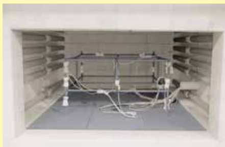
アニーリング炉での測定設置
